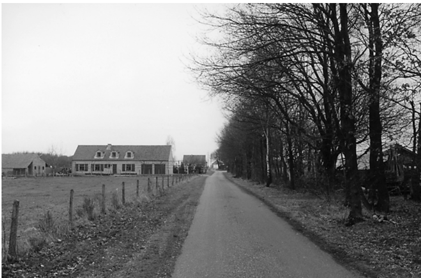
Foto 8: Voorbeeld lokale weg III (erftoegangsweg) in buitengebied: landelijke weg. Rijbaan 3-4 m met grasberm. Kleine landschapselementen als natuurlijke groenstructuur.
