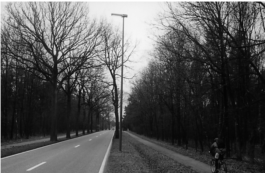
Foto 1: Voorbeeld lokale weg I: Lokale verbindingsweg in het buitengebied. Dit type toont zich het meest optimaal in het buitengebied. Rijbaan 6 m. Gescheiden fietspaden. Laanbeplanting (hier een oude dreef). Bij vernieuwing van deze wegen worden in overgangsgebieden de nieuwe bomen meer tegen het fietspad geplaatst om het uitzicht te verbeteren vanaf de uitritten van percelen.
