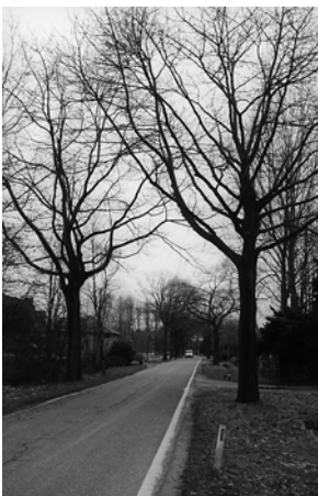
Foto 2: Voorbeeld lokale weg II (gebiedsontsluitingsweg): een wijk/deelkern-ontsluitingsweg in landelijk gebied. Rijbaan 5 m. Laanbeplanting (hier volwassen). Gemengd verkeer bij lage intensiteit.
